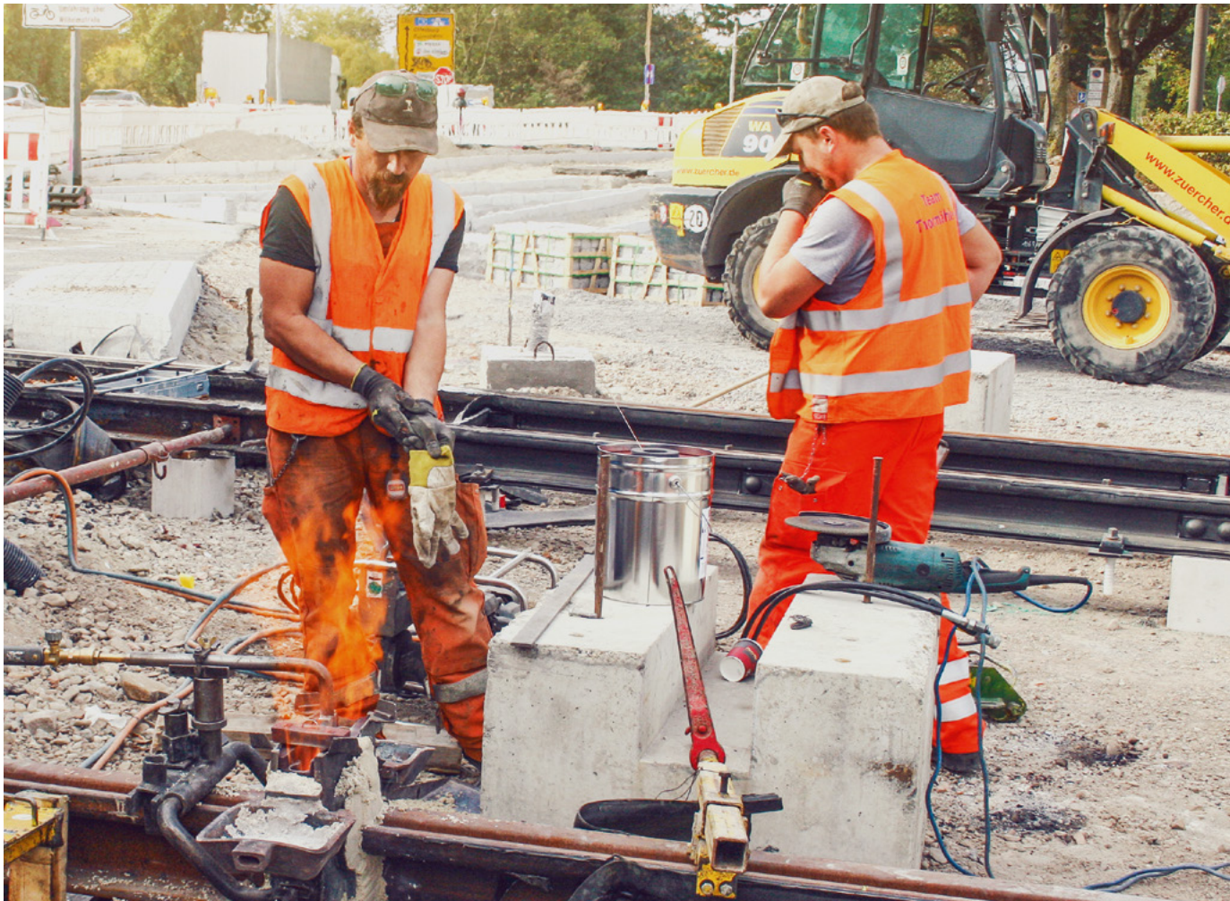
Letzte Schweißnaht an der neuen Stadtbahnlinie
