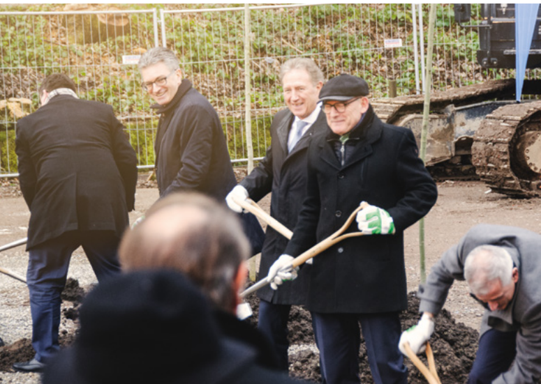
Offizieller Spatenstich zum Baubeginn auf der Höllentalbahn West in Anwesenheit des baden-württembergischen Ministers für Verkehr, Winfried Hermann
