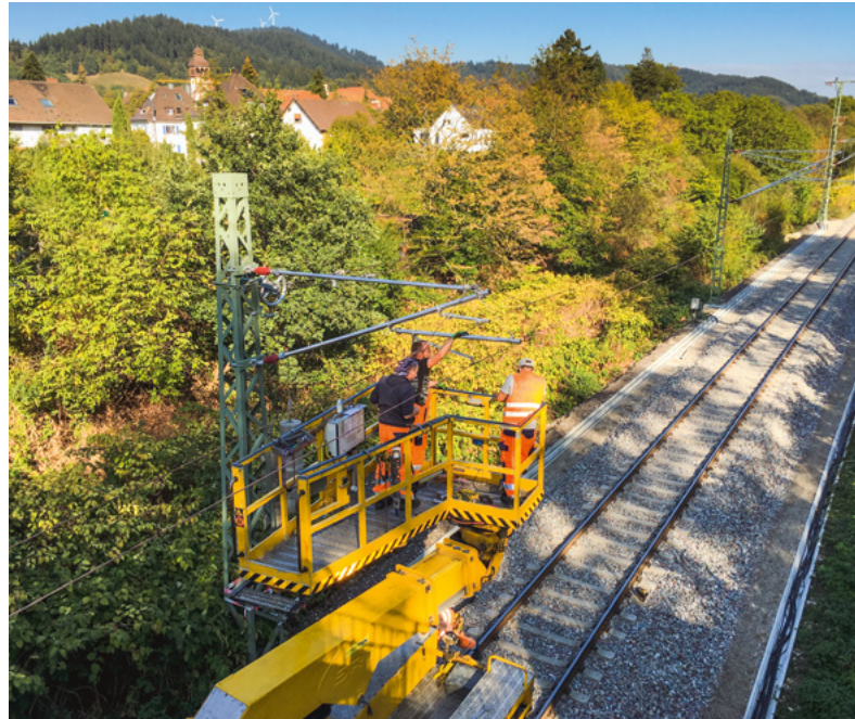
Letzte Arbeiten vor der Wiederinbetriebnahme
